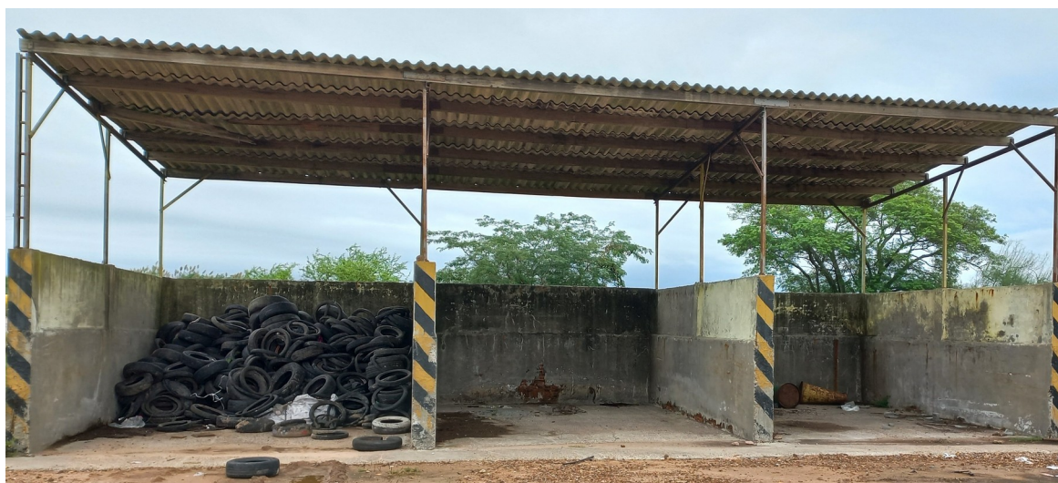
FIGURA 25: Sitio de acopio transitorio de NFU en el relleno sanitario municipal.
