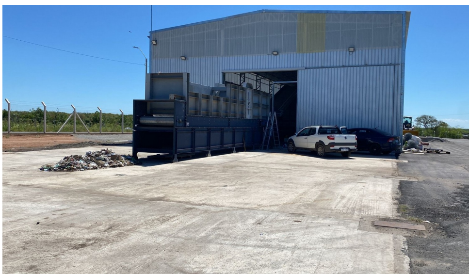
FIGURA 51: Vista exterior de la planta de gestión de residuos construida por la IdeP.
