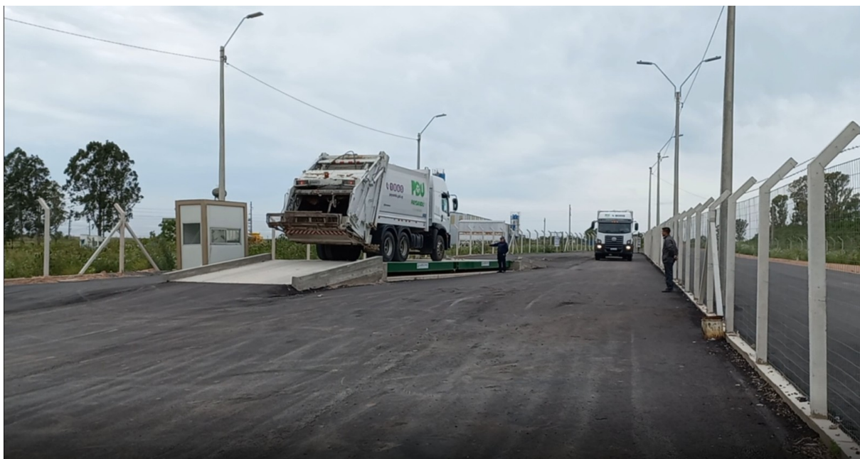
FIGURA 58: Balanza, puesto de control, vías de circulación interna y cerco perimetral.
