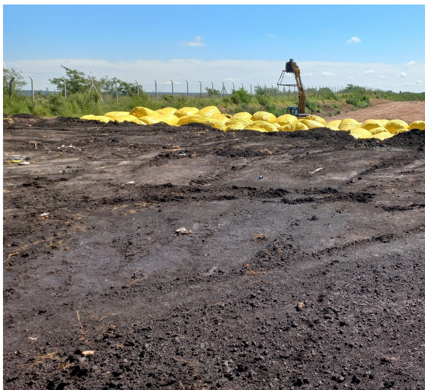
FIGURA 57: Cobertura de cápsulas en celda de disposición final.
